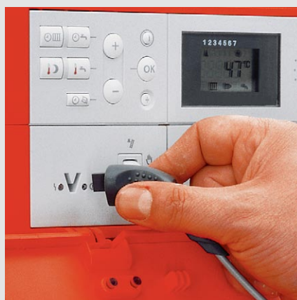
Rys. 76: Szybkie połączenie za pomocą sprawdzonego interfejsu dla laptopów firmy Optolink
