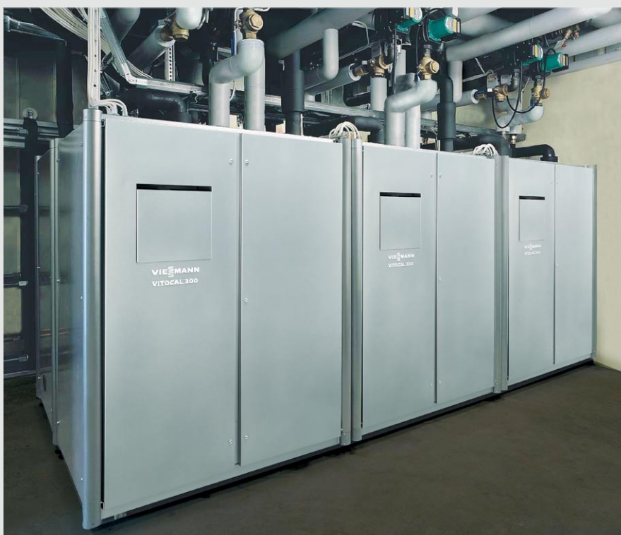
Rys. 59: Lokalna osiedlowa instalacja ciepłownicza w Szwecji – sześć pomp ciepła woda/woda Vitocal 300 dostarcza łącznie moc grzewczą 640 kW
