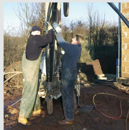
Rys. 27: Zakładanie sondy gruntowej
